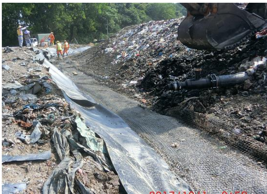
图 8.3-4 垃圾堆体坡脚碎石盲沟构建图
