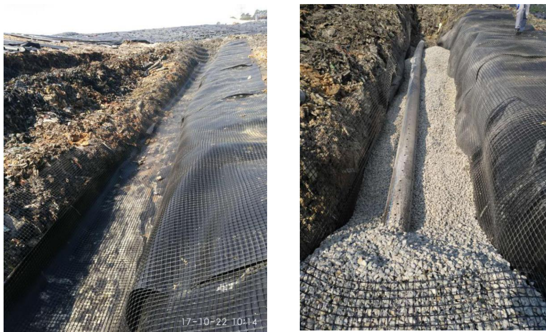
图 8.3-6 渗滤液水平导排盲沟构建现场图
