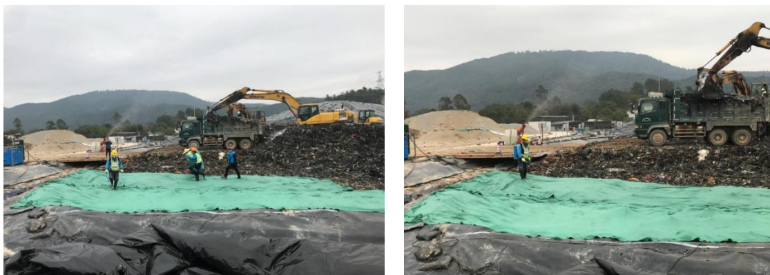
图 8.1-15 土工布除臭覆盖
