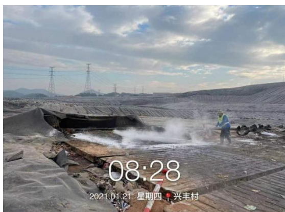
图 8.1-12 道路喷洒生石灰
