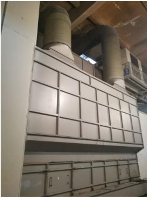
密闭喷漆房废气收集系统
