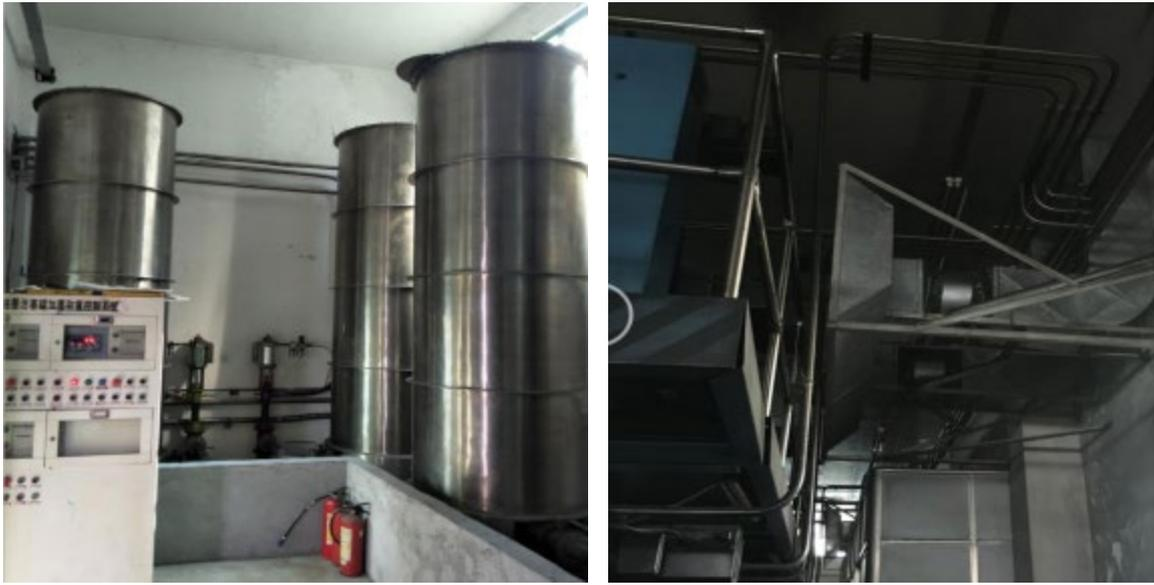
图 2.2-1 20#企业油墨储存及自动供墨系统 (a) 和自动供墨管道 (b)
