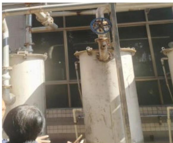
图 2.3-8 真空泵系统第二级除油罐
