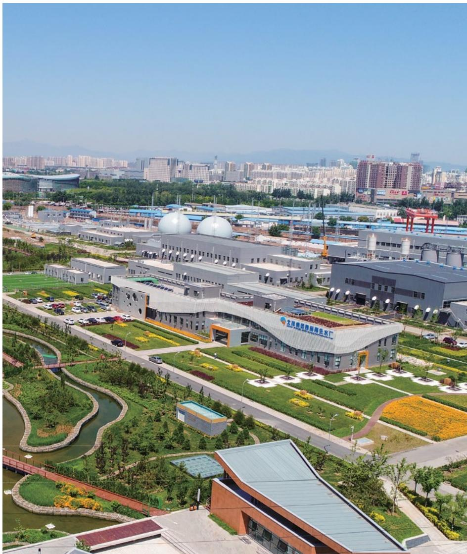
中国政府正推进长江经济带的高水平可持续发展，苏伊士积极与地方展开合作，以实现绿色增长并保护和恢复长江生态系统的愿景。在重庆，苏伊士旗下唐家沱污水处理厂正在为这座中国最大的直辖市提供优质服务。该污水处理厂是中国西部设备和技术最先进的污水处理厂之一，执行全国最严格的污水排放标准，以避免对长江和三峡库区造成重大影响。项目采用先进的A-A2O生物污水处理工艺和INNODRY®2E污泥干化工艺，利用尾水发电以节省10%的用电，中水回用节约了94%用水。该项目每年可节约400万立方米天然气、550千瓦时电力以及370万立方米用水，有效保护水资源，改善重庆居民的生活质量。
