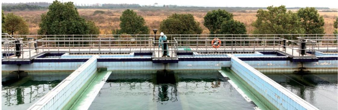
在青岛，董家口污水处理厂的工业污水日处理能力为20,000立方米，为董家口经济开发区的工业客户（包括港口、钢铁和化工行业）以及商业客户提供工业污水处理服务。污水处理厂处理相邻钢铁厂产生的工业污水，中水达到钢铁厂的工艺用水要求后回用，成为其生产用水。项目节省了淡水资源和用水成本，成为循环经济的一个很好的例子。
