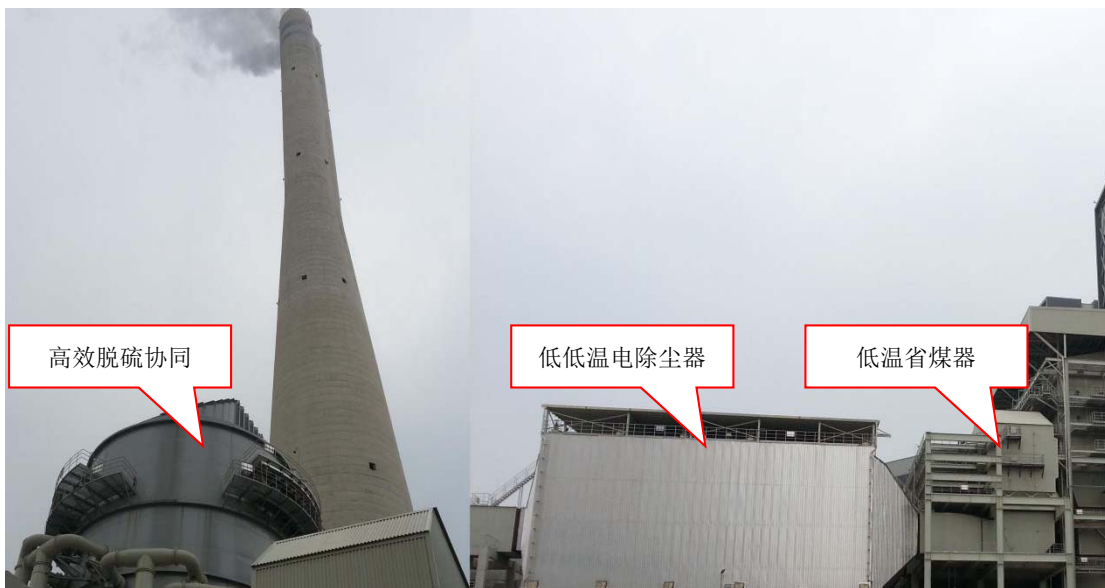
图 1.3-4 低低温电除尘器+高效脱硫协同除尘方案示意图
