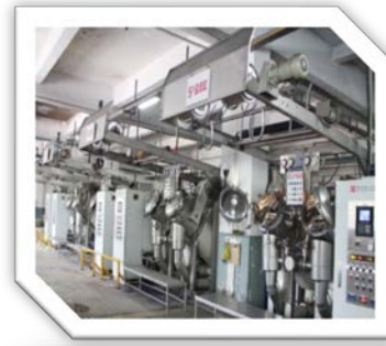
双罐 溢流 机改造
