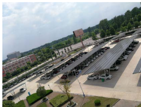
车棚光伏发电
