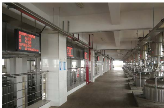
投料 LED 显示系统
