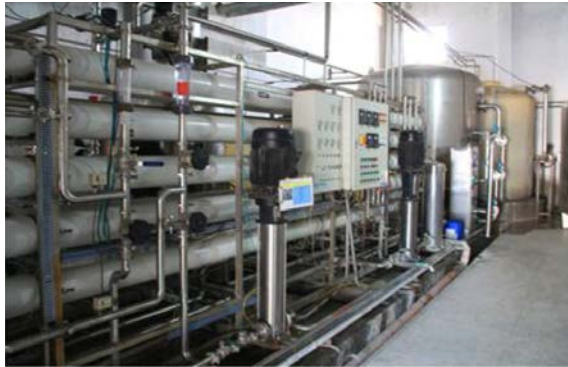
反渗透水处理系统
