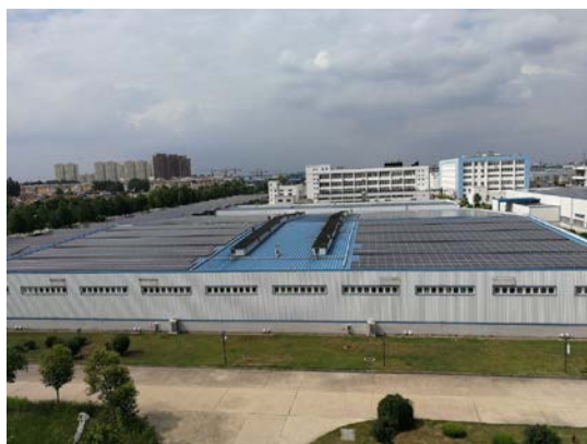
屋顶光伏发电
