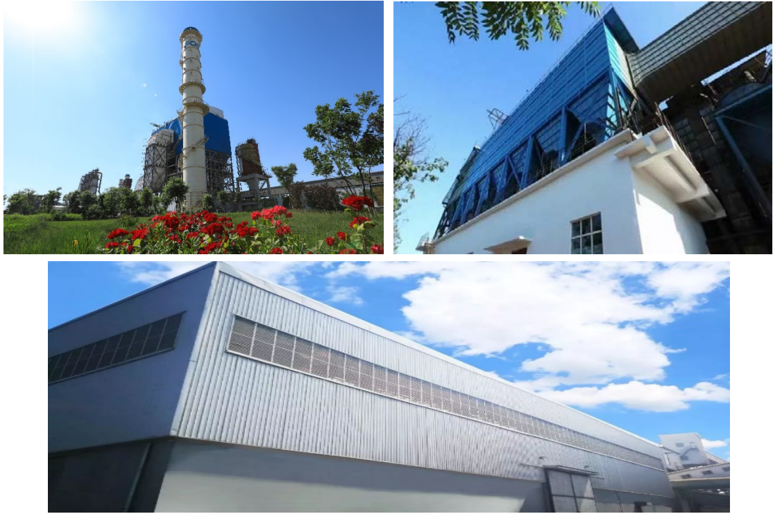
部分超低排放设备设施
