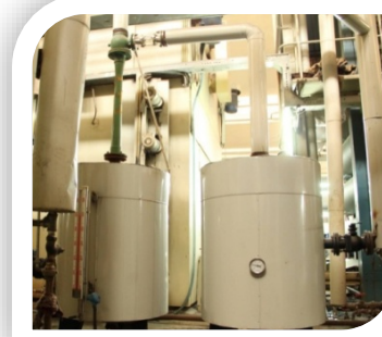
机台 凝结 水收集
