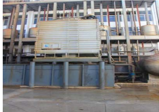
循环冷凝水箱
