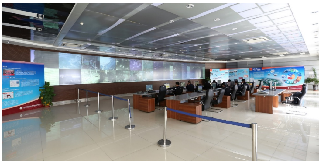
能源管控中心
