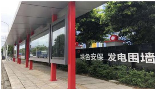
绿色安保——厂区周围建设的碲化镉发电玻璃围墙
