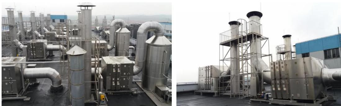
山东玲珑轮胎废气治理现场图及复合光催化装置图
